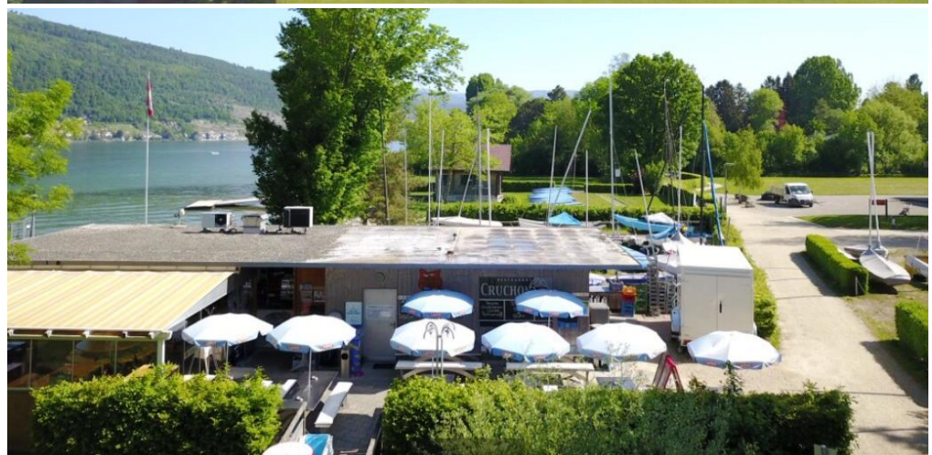
Situation Le Cruchon mit Lager- und Kühlraumfahrzeug (Quelle: www.lecruchon.ch )
