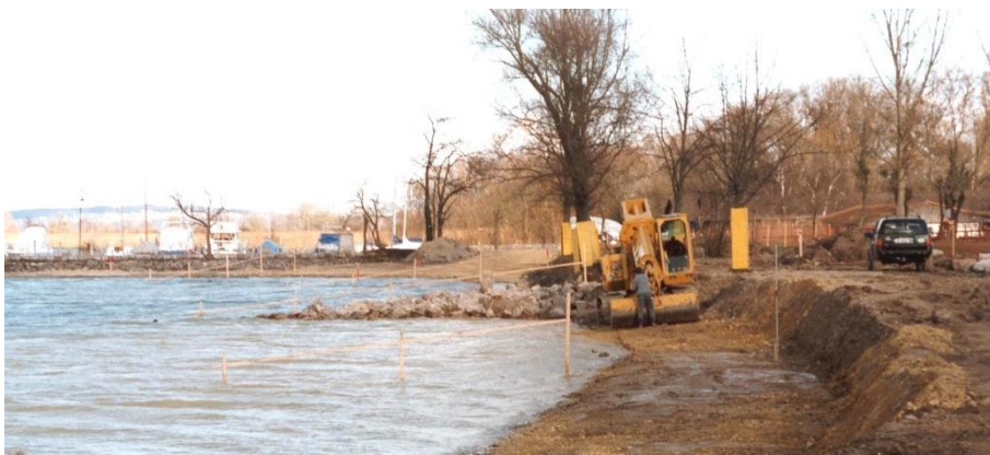
Abbildung 25) Beispiel Rückbau der Uferverbauung und Böschungsabflachung (Strandbad Erlach).
