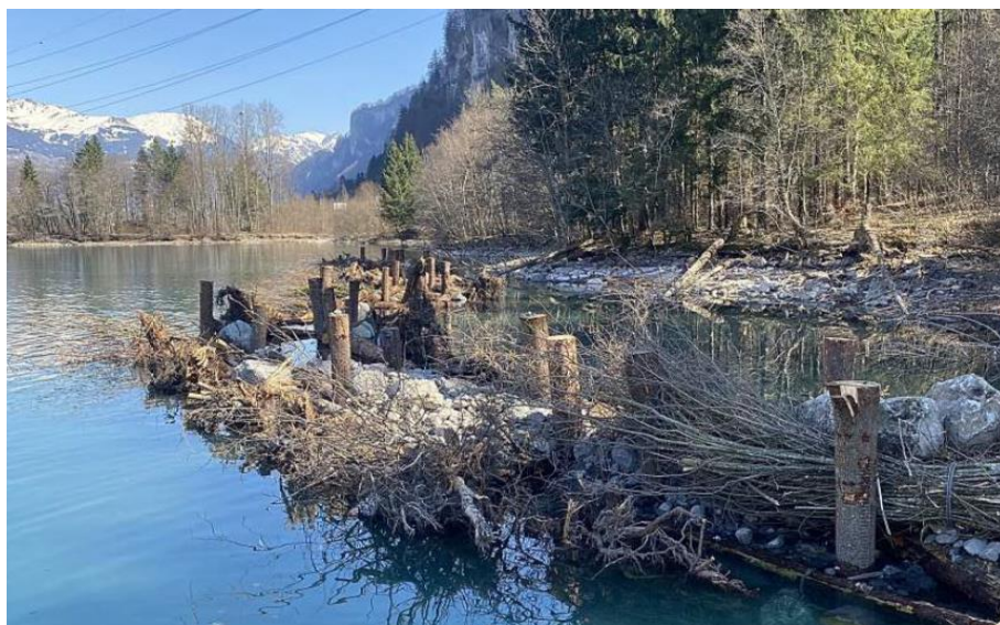
Abbildung 21) Beispiel eines Holzriffs (Brienz, Mätzener & Wyss, Bauingenieure AG).
