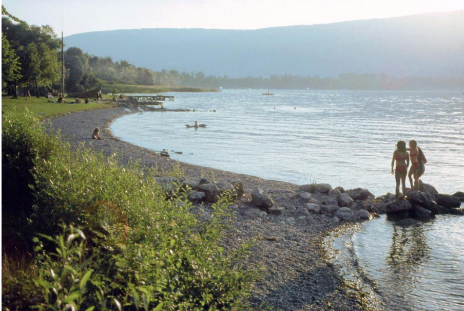
Abbildung 26) Beispiel einer Uferabflachung mit Kiesschüttung und Buhnen (Strandbad Erlach).
